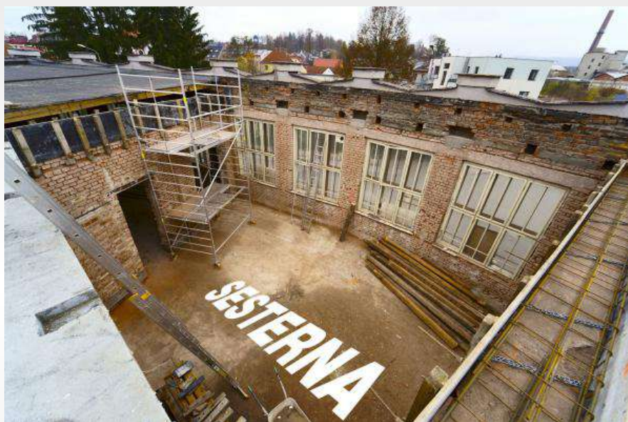
Stavební práce, které začaly v polovině roku, pokračují. Nová střecha musí být do konce roku na místě.
