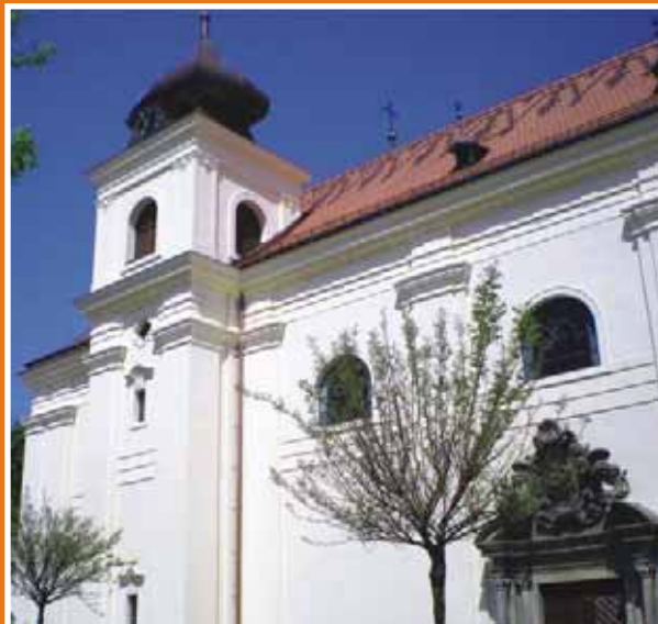
Nově opravený kostel sv. Anny
