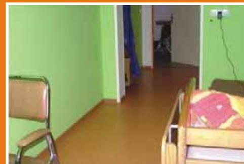
Nové PVC a elektroinstalace
