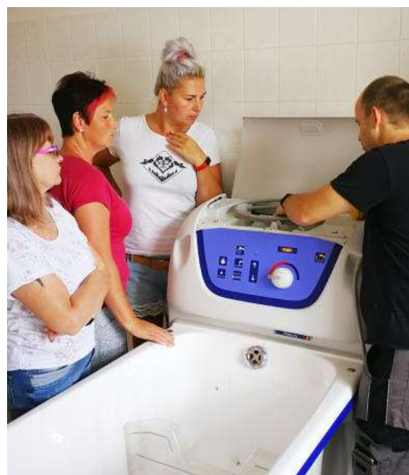
Instalace nové vany pro klienty CHPS.
