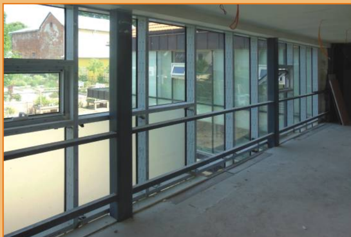
Průhled z objektu pivovaru do Bylinkové zahrady
